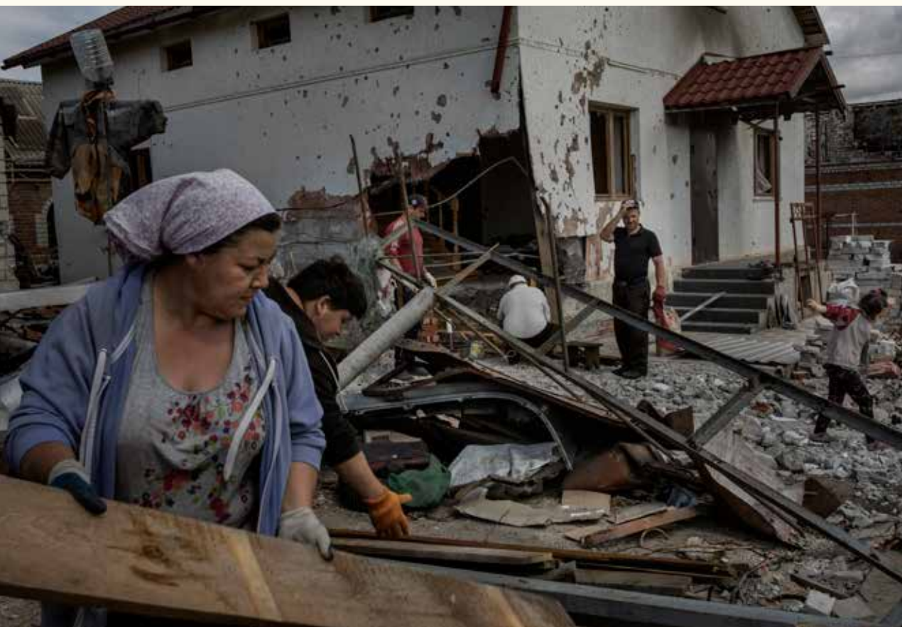
Mala Rohan, a est di Kharkiv, una famiglia rimuove i detriti e ricostruisce la propria casa distrutta da un missile russo. 14 maggio 2022.
